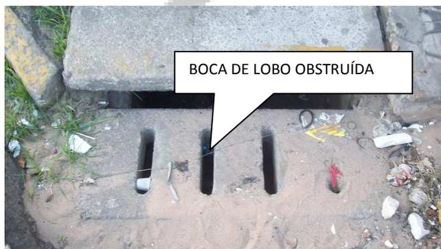
Galeria obstruída devido à presença de lixo, lama e areia dentro das bocas de lobo.
