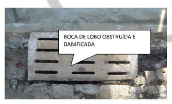
Galeria obstruída devido à presença de lixo, lama e areia dentro das bocas de lobo.
