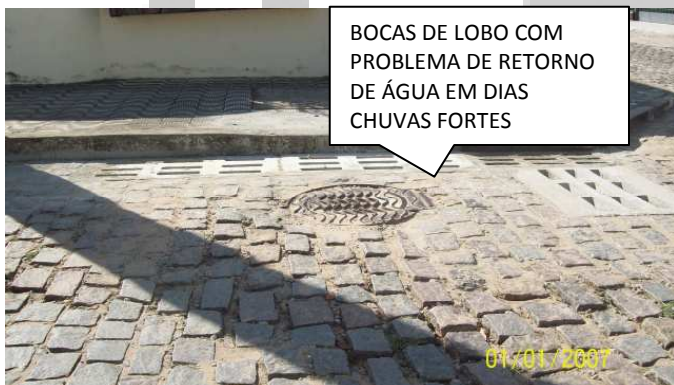
Bocas de Lobo no Cruzamento das Ruas Vale do Miranda e Souza Pinto.
