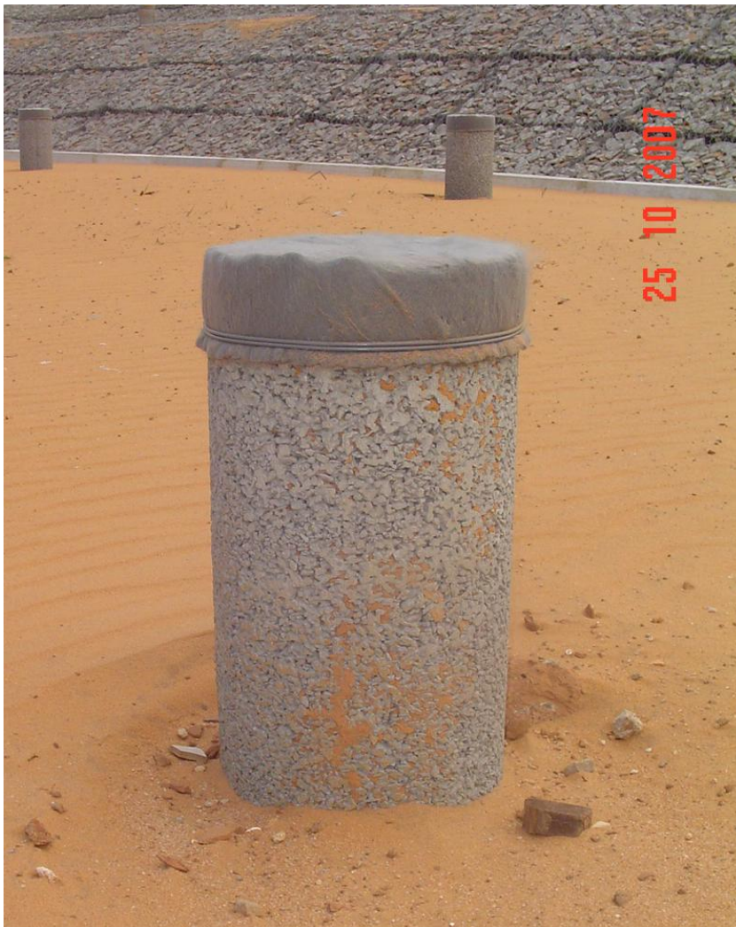
Figura VIII.7 – Detalhe de dreno vertical com tubo poroso
