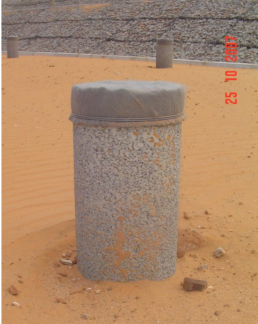
Figura 07 – Detalhe de dreno vertical com tubo poroso
