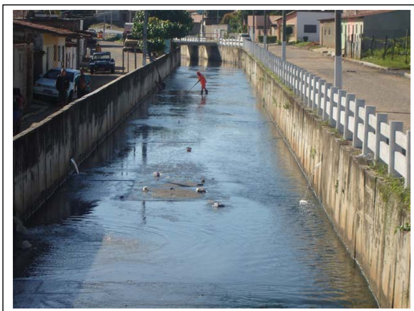
Figura 01 – Gari realizando limpeza do Canal das Lavadeiras
