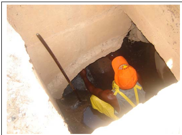
Figura 3 – Limpeza de tubulação acima de 800 mm
