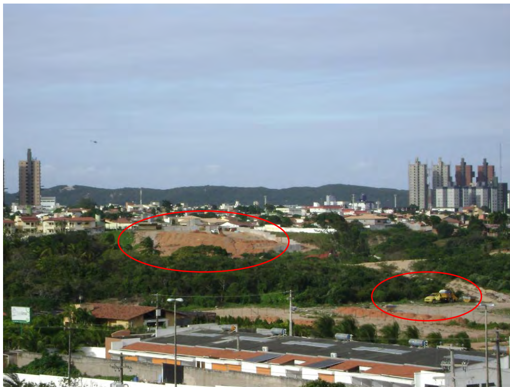
Fonte: Visita Técnica à Região Sul de Natal, Start, agosto/2008.
