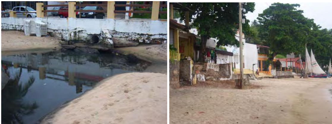
FIGURA 140. A) Ligações clandestinas no sistema de drenagem B) Ocupação irregular da Orla de Ponta Negra.
