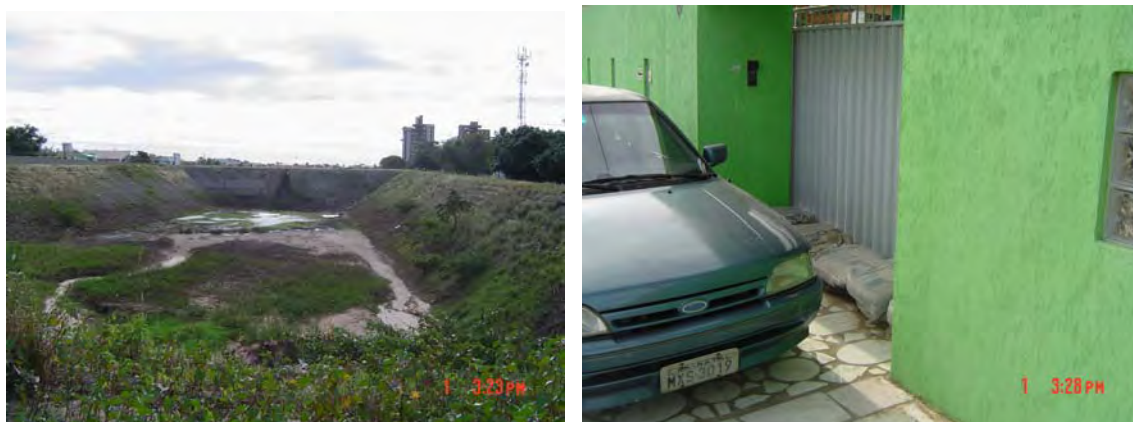
FIGURA 133. a) Vista parcial da lagoa situada na Av. Jaguarari. Vê-se grande quantidade de Esgotos domésticos. b) sacos de areia protegem as casas das inundações da lagoa.
