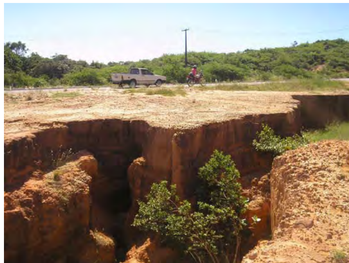
FIGURA 42. Processo erosivo com voçorocamento na Zona Norte de Natal
