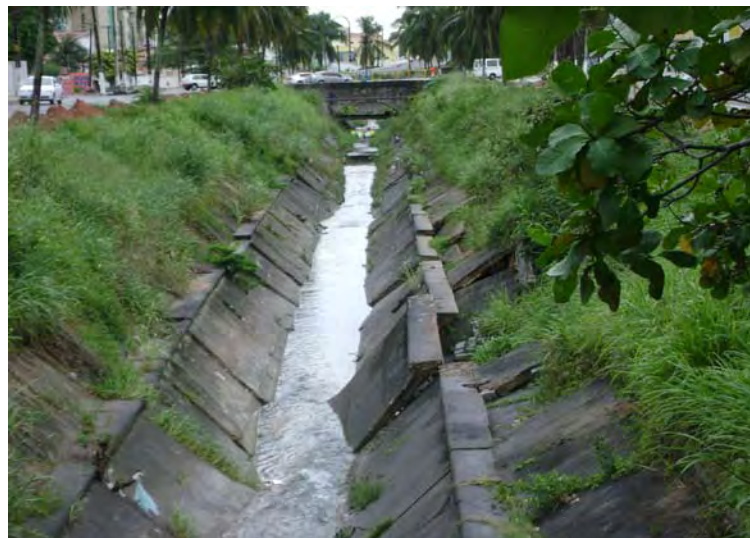
Figura 47. Canal do Baldo retificado em estrutura de concreto
