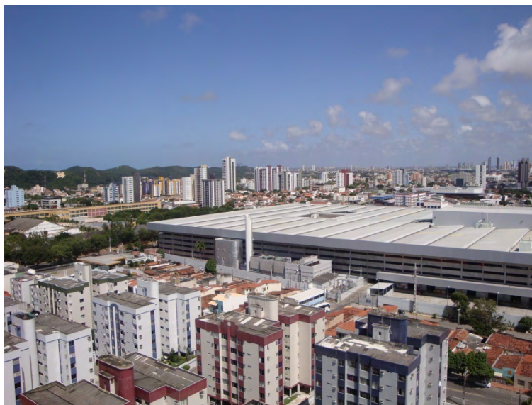
FIGURA 128. Vista parcial da área de Drenagem da Bacia.
