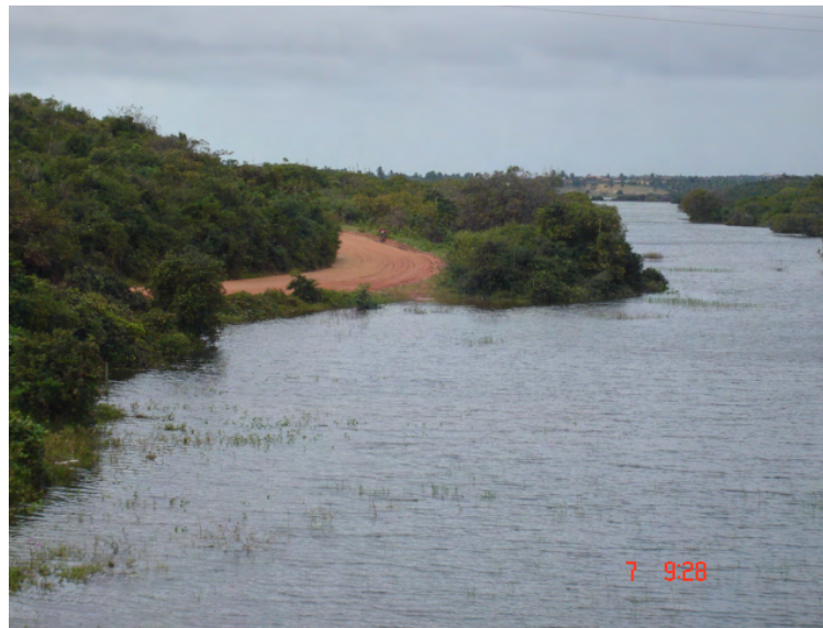
Figura 51. Expectativa de transbordamento das águas da lagoa do Sapo sobre a Moema Tinoco. Em direção Oeste localiza-se a vertente direita do Rio Doce
