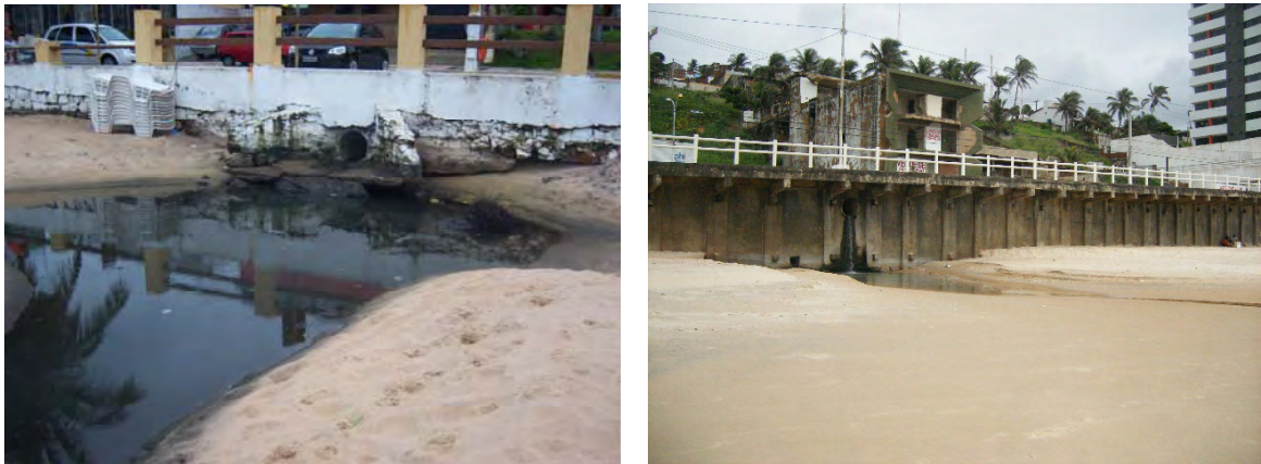
FIGURA 27. Tubulação de águas pluviais despejando efluentes domésticos nas areias das praias de Ponta Negra e de Areia Preta, Natal/RN
