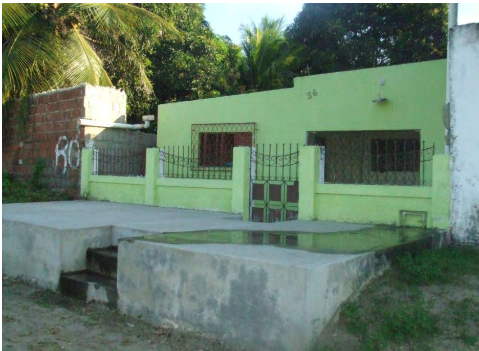
Figura 27 - Construção de barreiras para evitar a entrada da água
