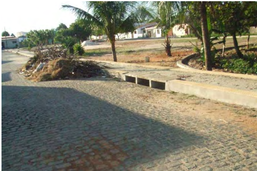
Figura 25 - Galerias localizadas na Praça
