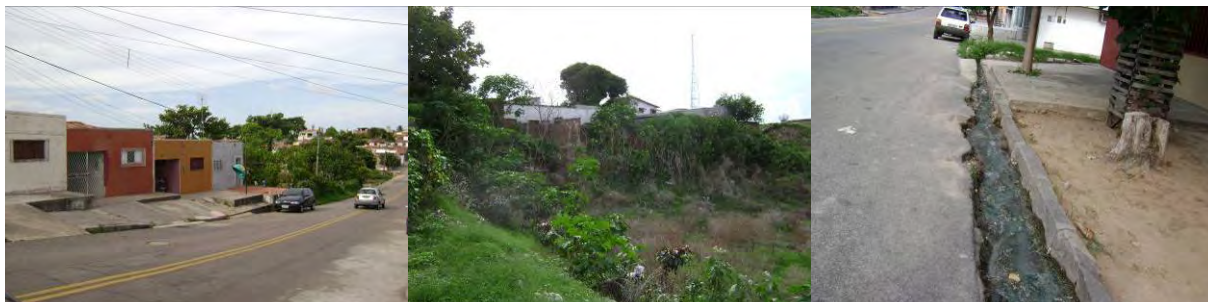
Figura 86, 87 e 88: 86 – Uso residencial; 87 – habitações em risco de deslizamento; 88 – falta de saneamento.
