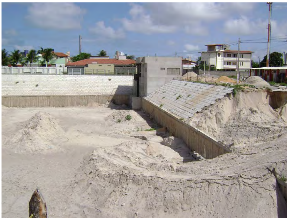
Figura 135 - Lagoa em fase de construção.
