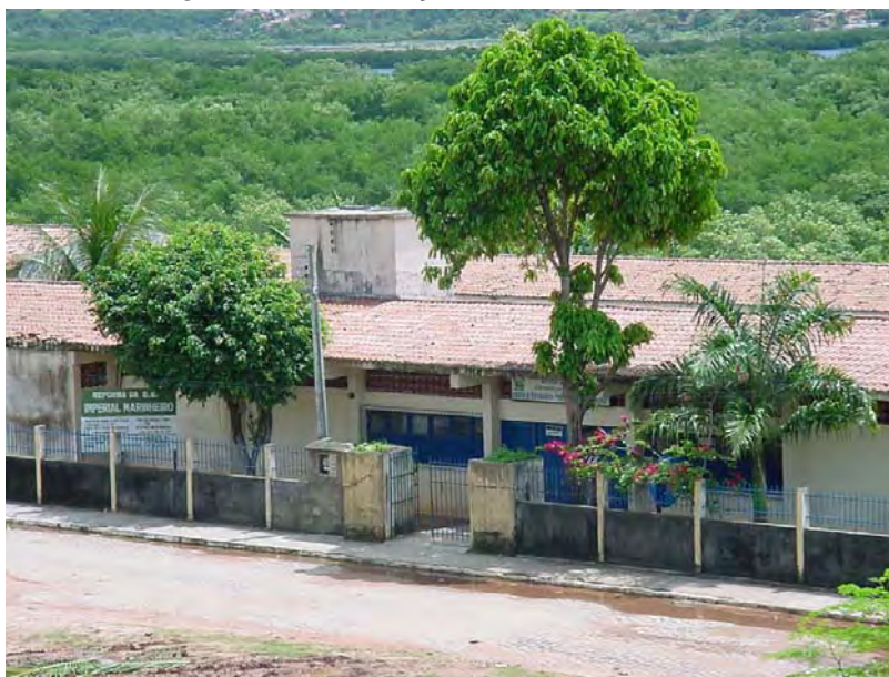
Figura 52 - Edificação no bairro Nordeste.
