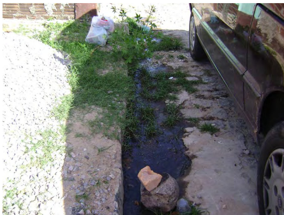
Figura 165 - Presença de esgoto a céu aberto.
