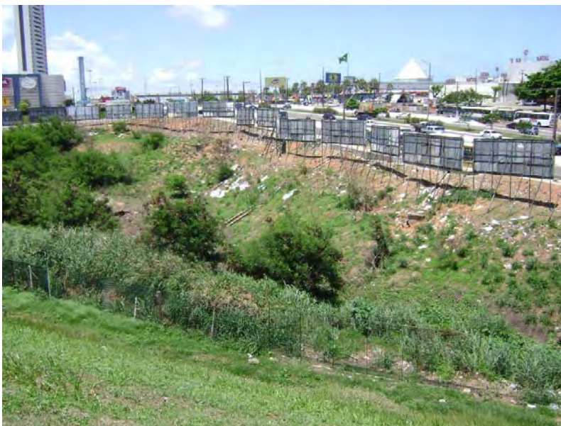
Figura 114 - Presença de lixo na área da Lagoa.
