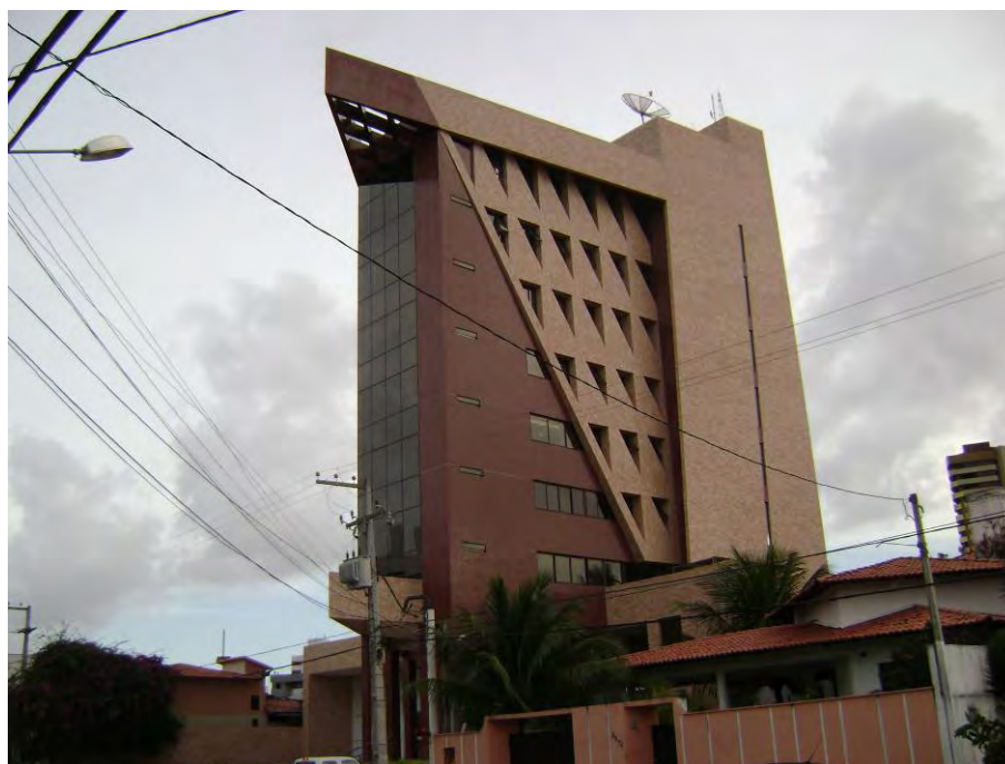
Figura 102 - Edifício de uso comercial e serviço.
