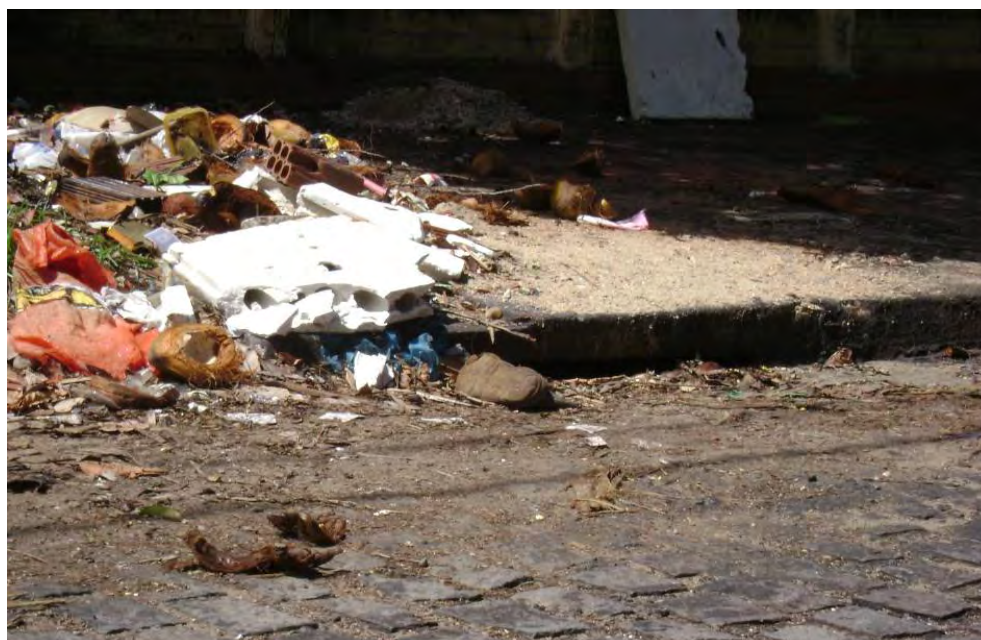
Figura 147 - Deposição de lixo nas galerias.
