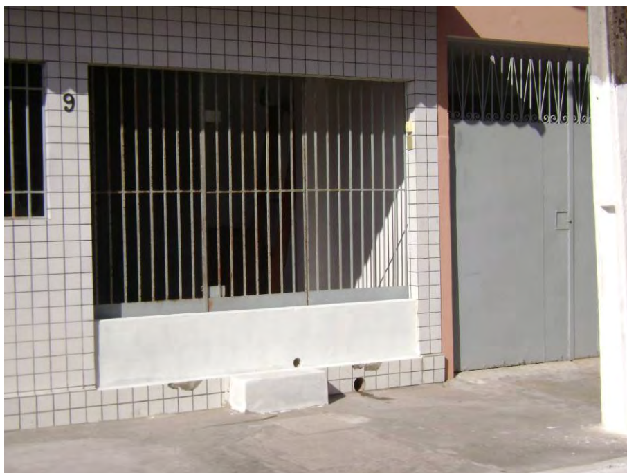
Figura 161 - Medida de contenção da água da chuva.
