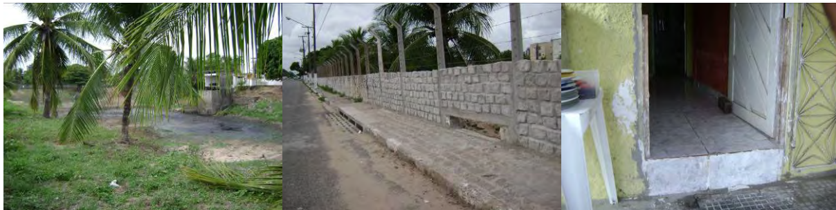
Figura 95, 96 e 97: 95 - Vista da Lagoa do Preá; 96 – Bocas de lobos; 97 – Medida paliativa utilizada.
