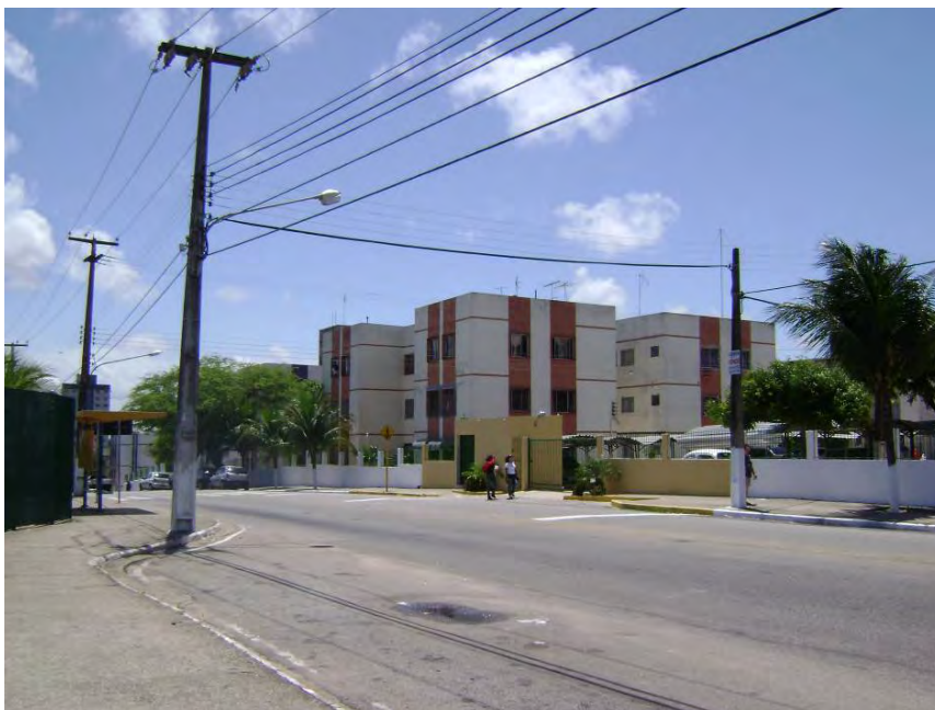
Figura 113 - Condomínio residencial Bairro Latino.
